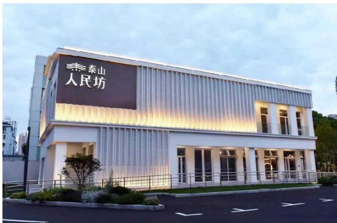
泰山人民坊改造后
